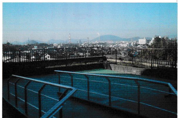
3階テラス部分にスロープを設置。素晴らしい眺望が広がります
