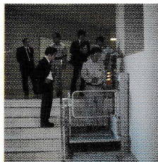
25教室へ行くための昇降機設置
