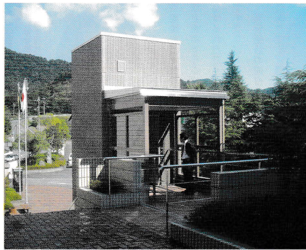
図書館利用のためのエレベーター設置
