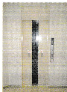
防火扉の備ったエレベーター。短大校舎の1階から5階に車イスで利用可能。その脇には各階身障者用トイレを設置
